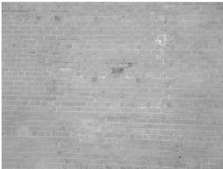
3.attēls. Ēkas ķieģeļu sienām dažviet konstatēta neliela ķieģeļu drupšana lietus un mitruma ietekmē.
